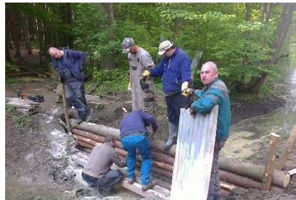
Rybáři postavili před rybníkem menší hráz, která by měla zabránit volnému přitékání nečistot.
