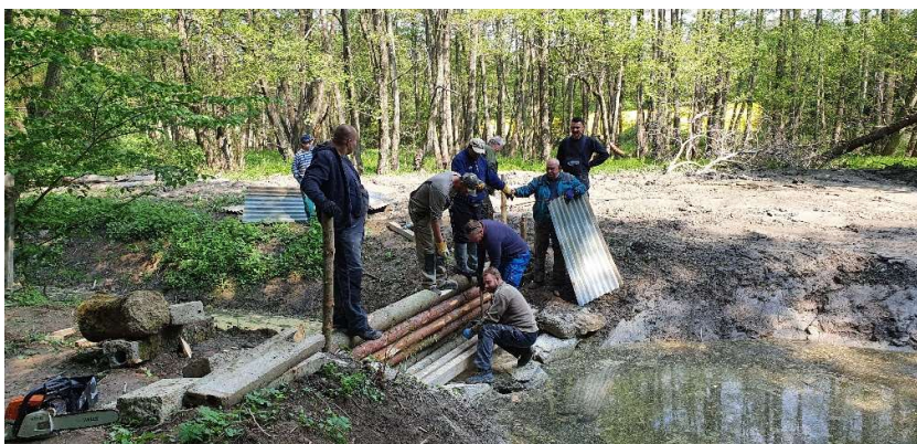
Rybáři postavili před rybníkem menší hráz, která by měla zabránit volnému přitékání nečistot.
